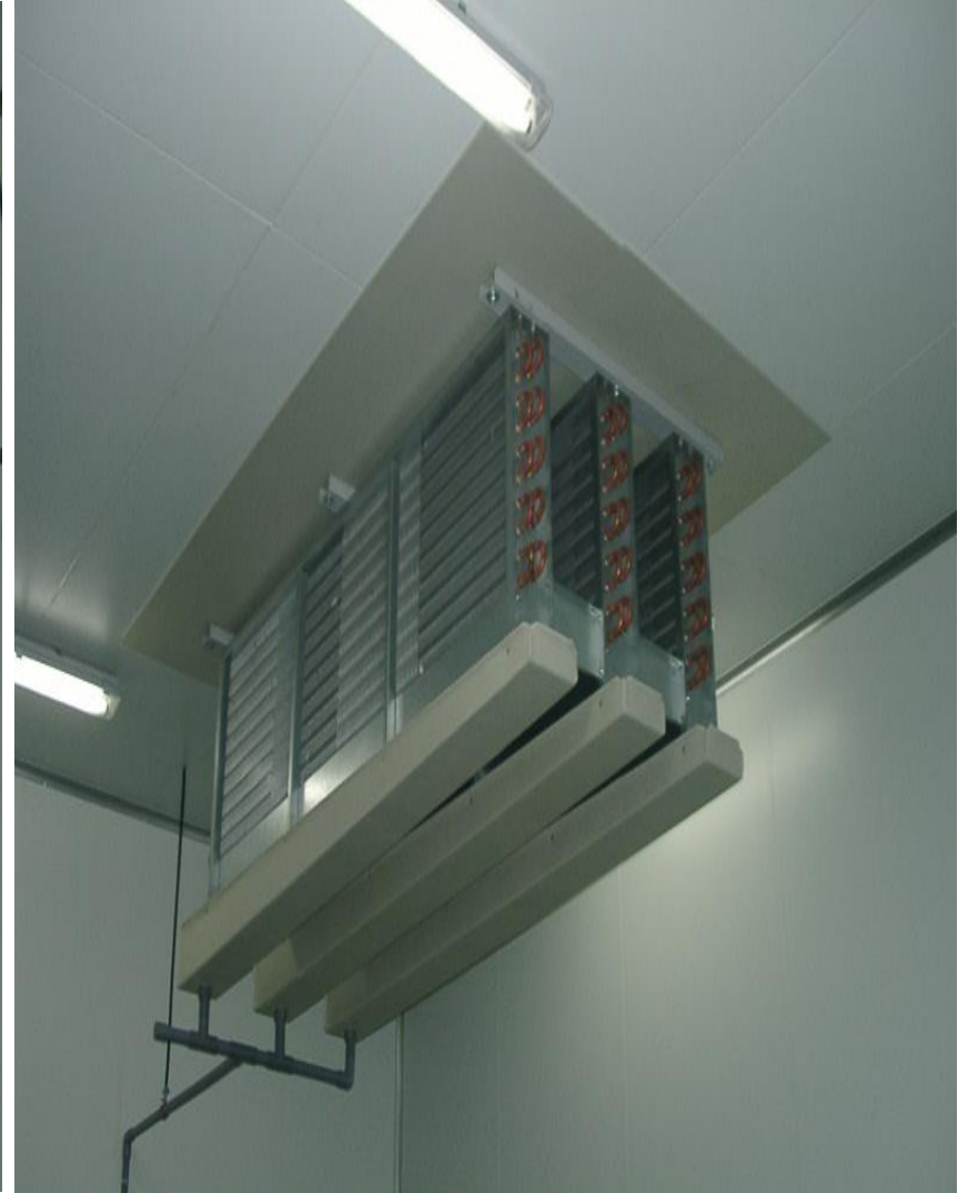
냉각팬 및 냉각코일에 설치된 응축수 배수관 설치 사례
