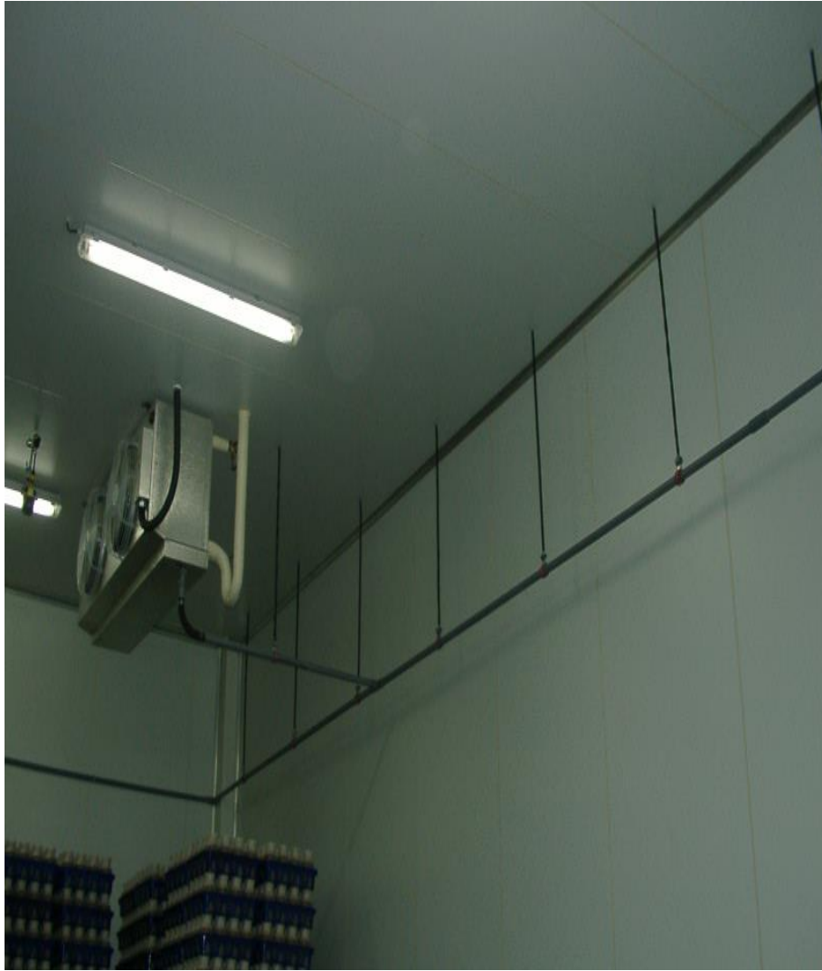
냉각팬 및 냉각코일에 설치된 응축수 배수관 설치 사례
